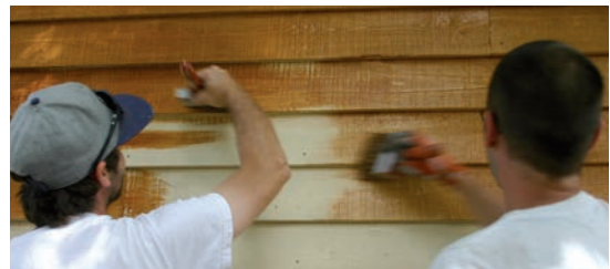
PHOTO 2 - UN REBORD MOUILLÉ DOIT TOUJOURS ÊTRE PRÉSENT
